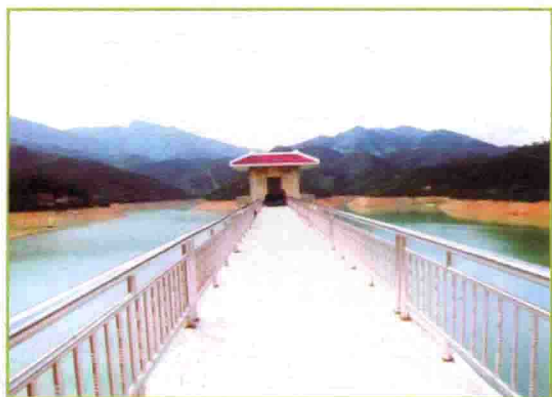
▲ 虎局供水工程（1996年4月9日竣工）
