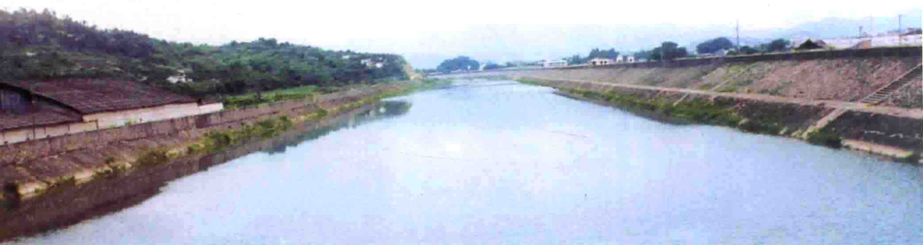
▲ 榕江北河改造工程（1994年9月27日竣工）
