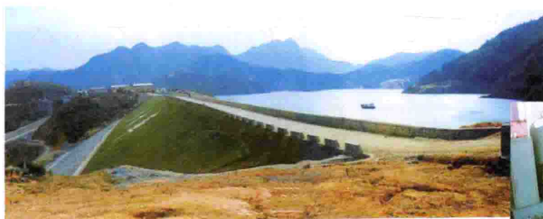
▲ 八乡水库（1995年6月19日竣工）
