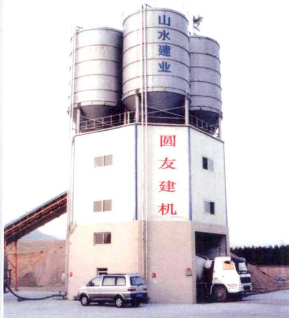
八角形商品混凝土搅拌楼
