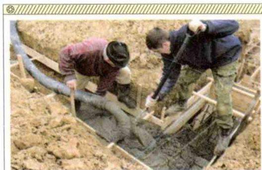
混凝土浇筑
