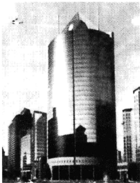
图 1-6 北京航华科贸中心 O1 楼
