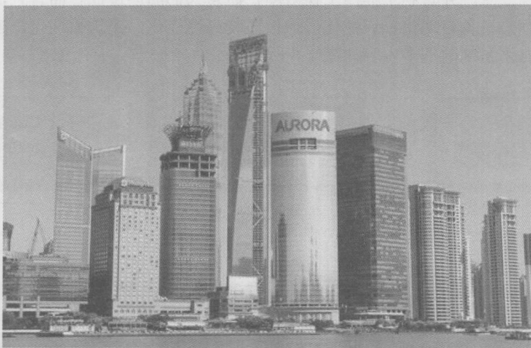
图 1-5 上海浦东的智能楼宇的超高层建筑
