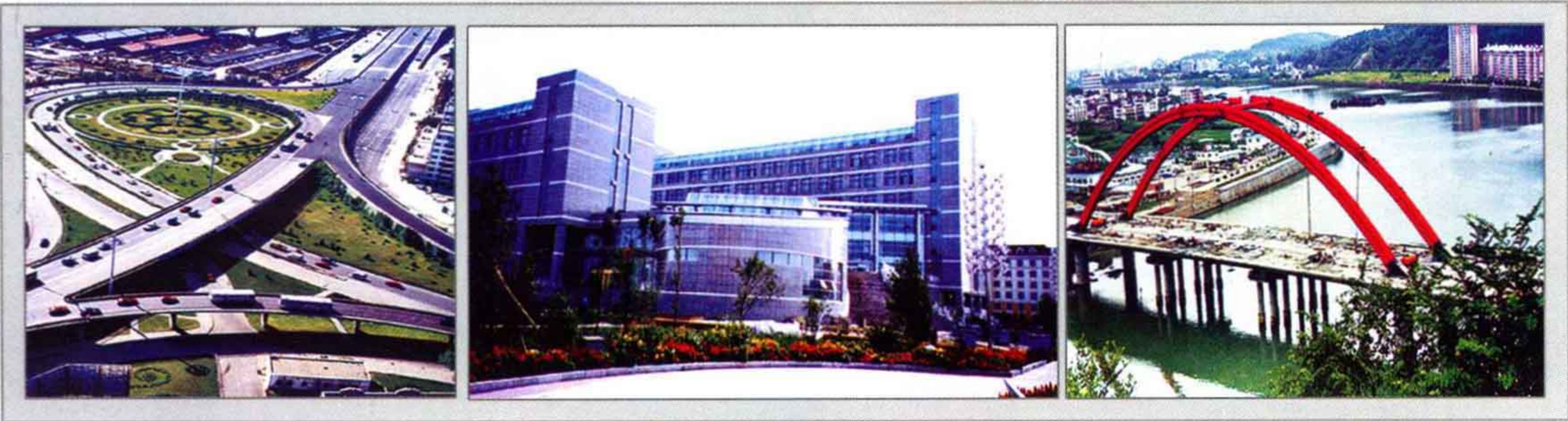
南直公路立交桥
