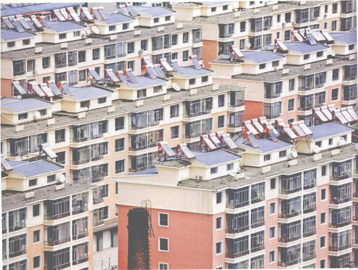
公寓楼上的太阳能热水器，中国珲春 来源：联合国人居署/Alessandro Scotti
