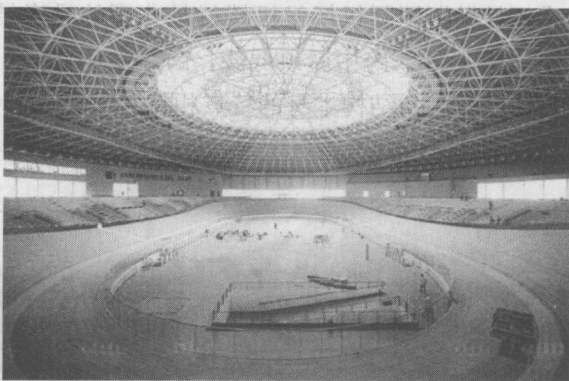
图 1-5 空间网壳结构——老山自行车馆
