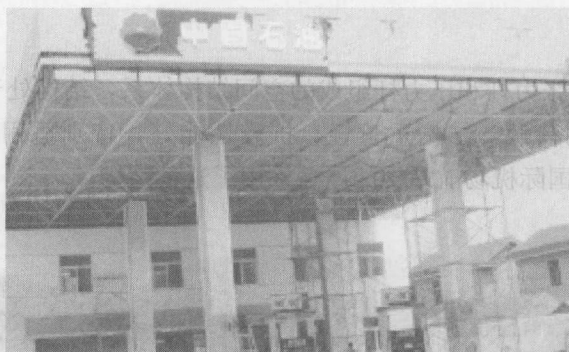
图 1-4 加油站平板网架结构
