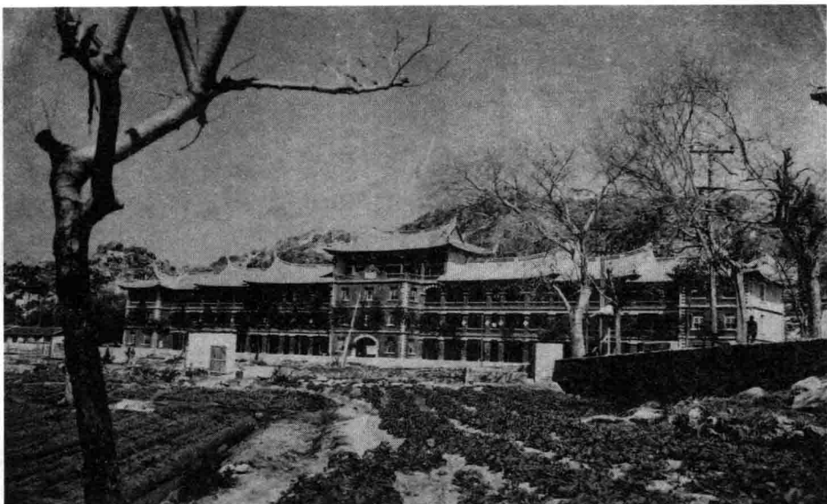
厦门大学芙蓉楼
