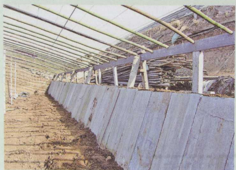
温室前脸内侧的 土壤修整成斜坡 并设置水泥板
