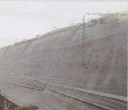
聚乙烯塑料膜 覆盖保墙体
