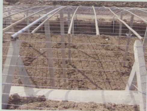
日光温室 骨架结构
