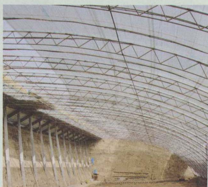
单立柱 110 型日光温室内部结构图
