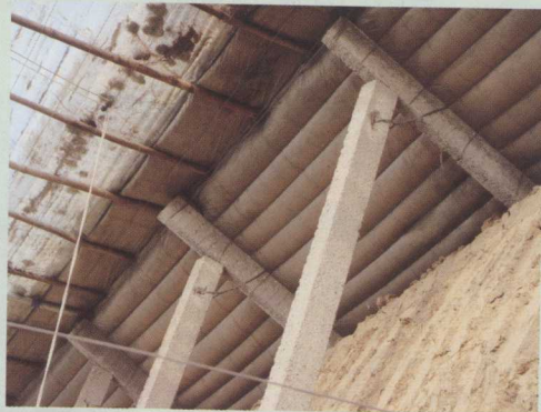
日光温室后屋 面内部结构
