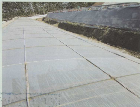
日光温室上加 布套的细钢索 横向压膜
