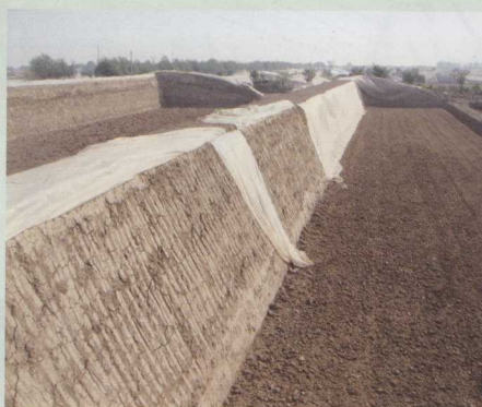
温室前脸内侧的 土壤修整成斜坡 并设置水泥板
