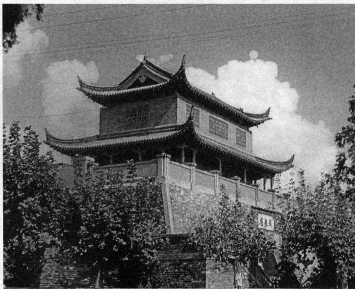
■ 周恩来祖籍浙江绍兴，祖辈迁居江苏淮安。这是淮安城内的镇淮楼。
