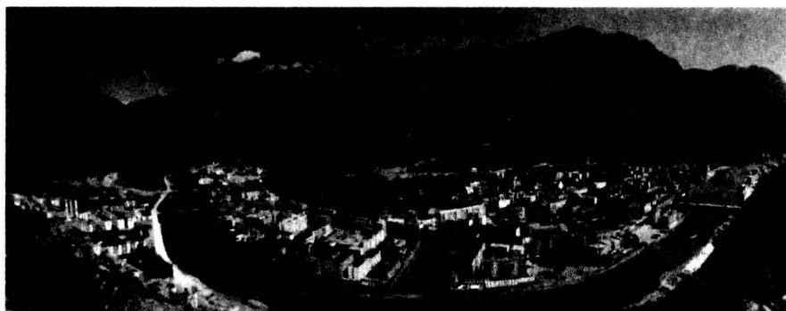
汶川县城震后全景照片
