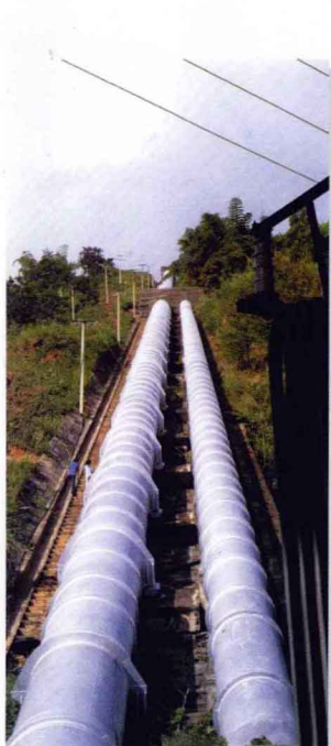
电厂压力管道
