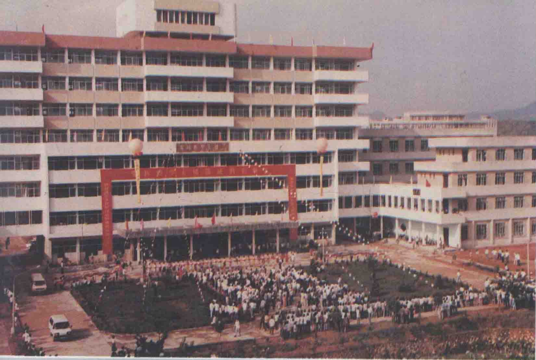
嘉应大学—宪梓教学大楼
