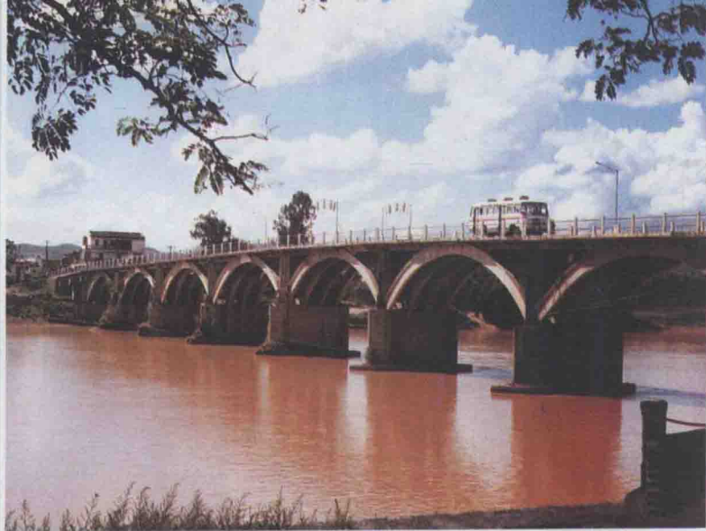
锦江桥(位于丙村镇)
