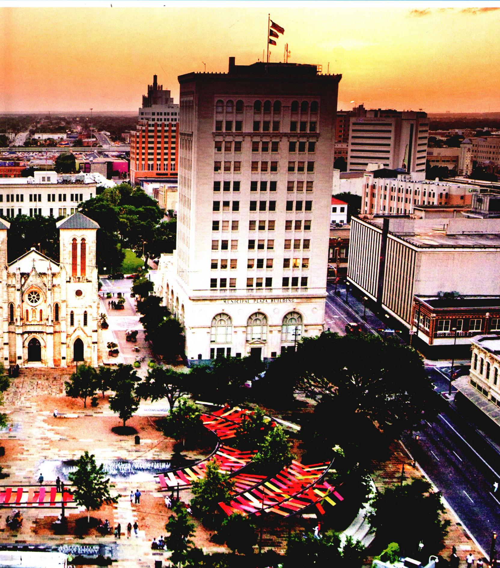
创新的单独格板系统设计拥有许多优点，如经济、环保、维护方便，费用低廉。如果某块格板坏了，只需更换该格板，而且颜色无须与周边的格板一致，因为该结构采用的是彩色格板组合。格板系统降低了结构承受的风力荷载，确保有足够的微风穿过，保证天棚下面的空气清新与凉爽。通过调整格板角度，遮阳棚在炎热的夏日能够提供最大限度的荫凉，而在寒冷的冬日又可透入更多阳光。可移动式桌椅使人们能够在任何时刻坐在最舒服的地方，也可以随意组合，适用于不同活动。经特别设计的荫凉区域用于休闲小憩，也是进行演出的最佳地点。
