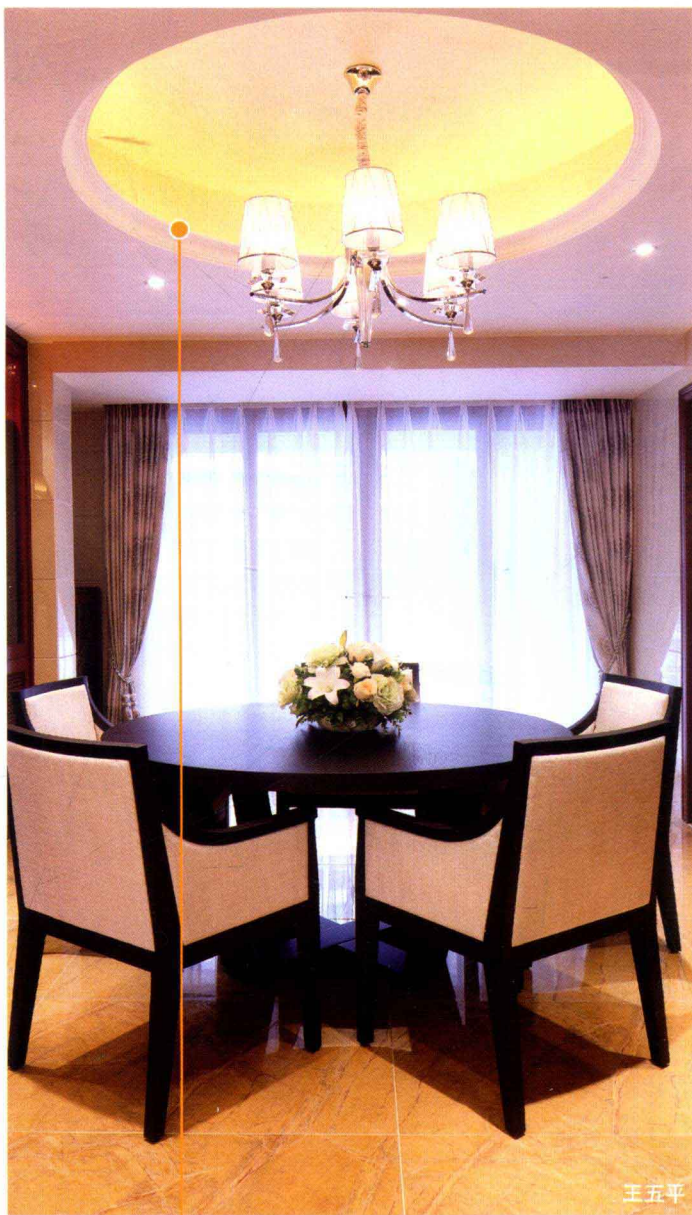
石膏板造型、乳胶漆
