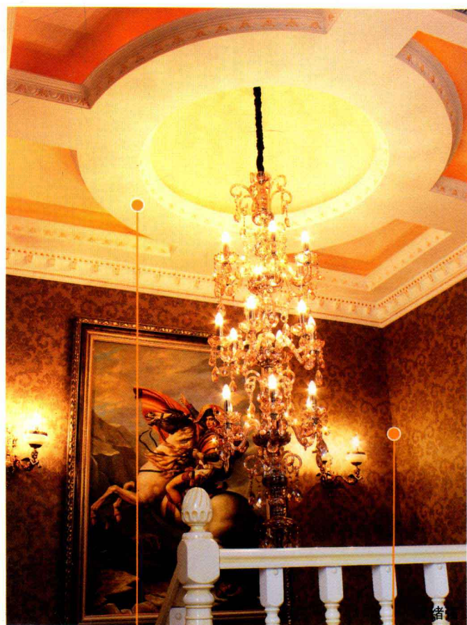
石膏板造型、乳胶漆
