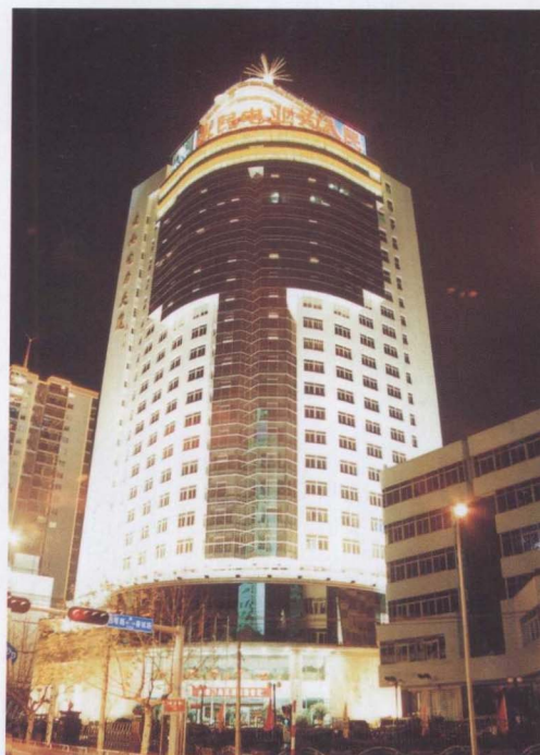
行协办公地点设在云南电力大厦
