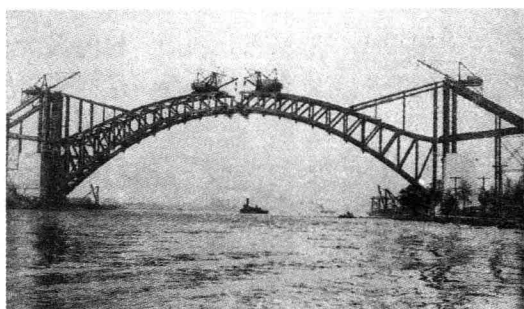
(a) 美国狱门桥, 悬臂施工法
