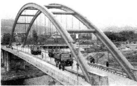
(a) 旺苍东河大桥
