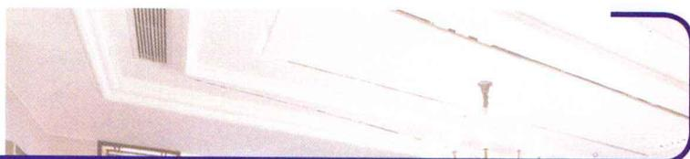
定义：跌级吊顶也称“高差吊顶”，是指不在同一平面的降标高吊顶，类似阶梯的形式。
