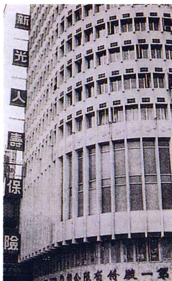
漢口大樓 55年5月—62年元月 台北市漢口街一段144號10樓
