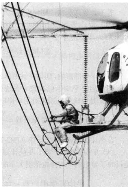
图 1-5 直升机等电位带电作业
