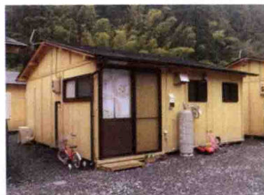
図6 木造仮設住宅
