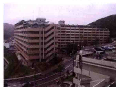
図10 阪神・淡路大震災の復興公営住宅
