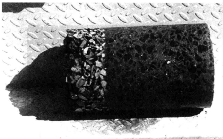
图 1-7 混凝土路面与排水层芯样
