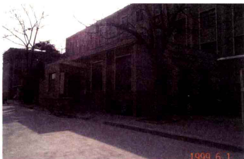
曾为图书馆馆舍八大处的学校总机房
