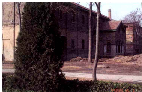
曾为图书馆馆舍八大处的西工字楼后一角
