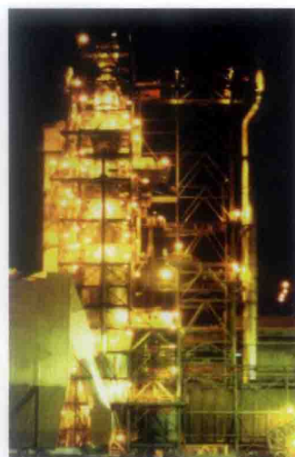
曲靖有色基地引进的艾萨炉
