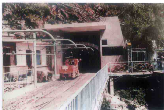
麒麟厂矿区出矿坑口
