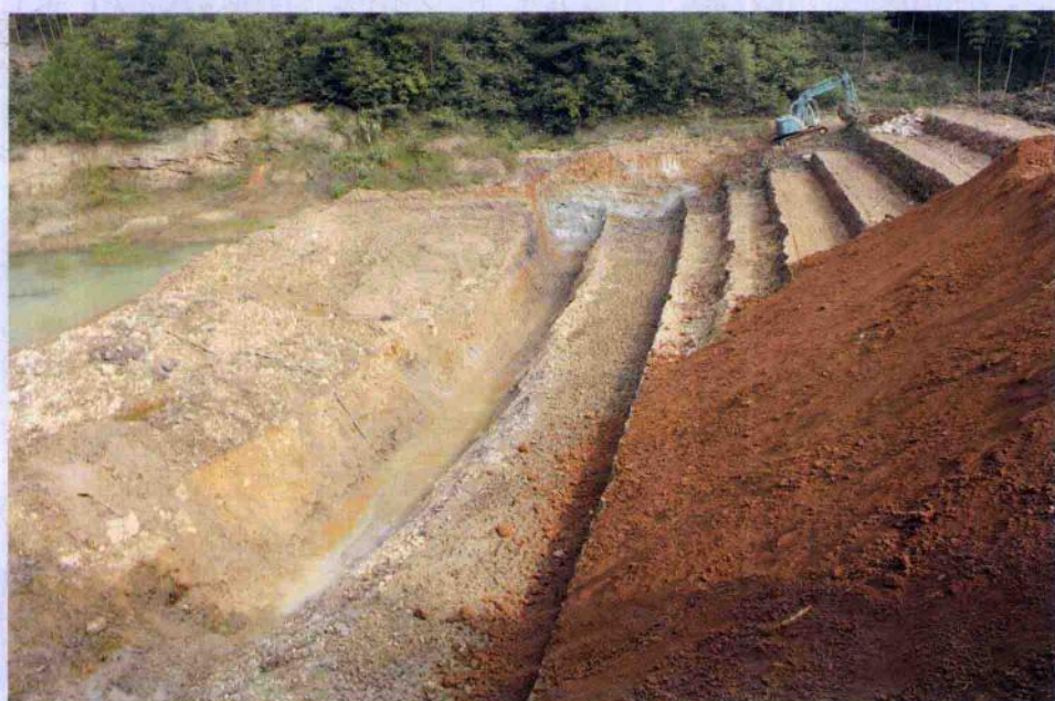
山塘斜墙开挖
