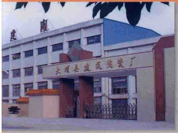
▲ 大埔县建筑陶瓷厂厂房一角
