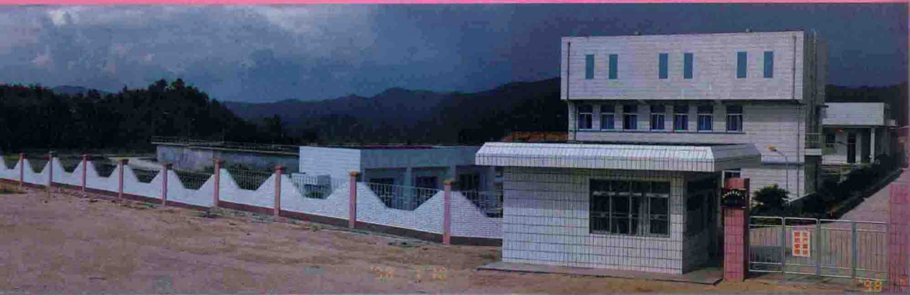
▲ 1997年7月1日，日产3万吨的虎山制水厂正式投产。图为虎山制水厂全貌
