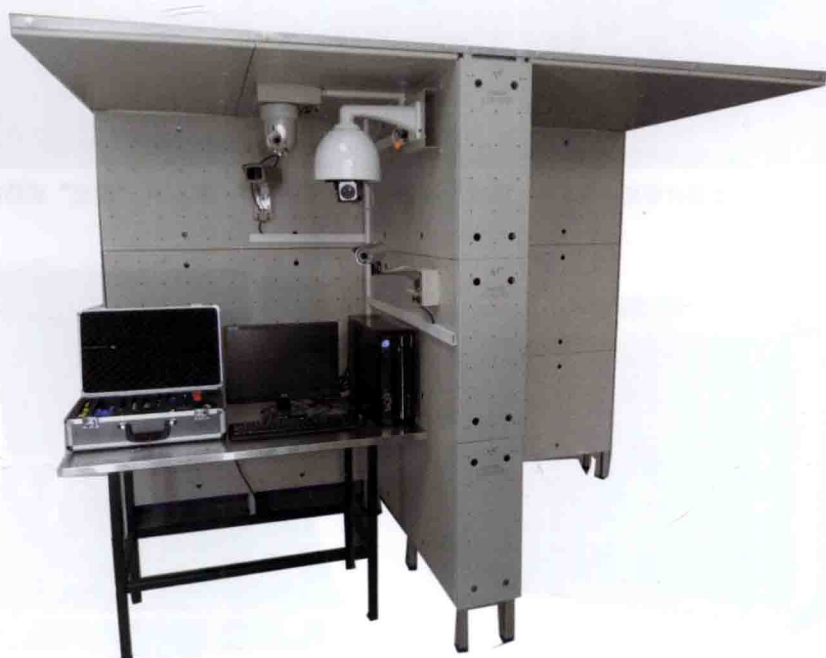
图5-38 在智能化安装实训装置上安装视频监控装置
