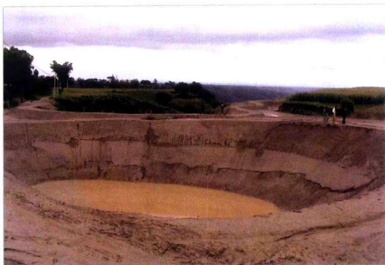
沟头综合治理 (张竿 摄)
