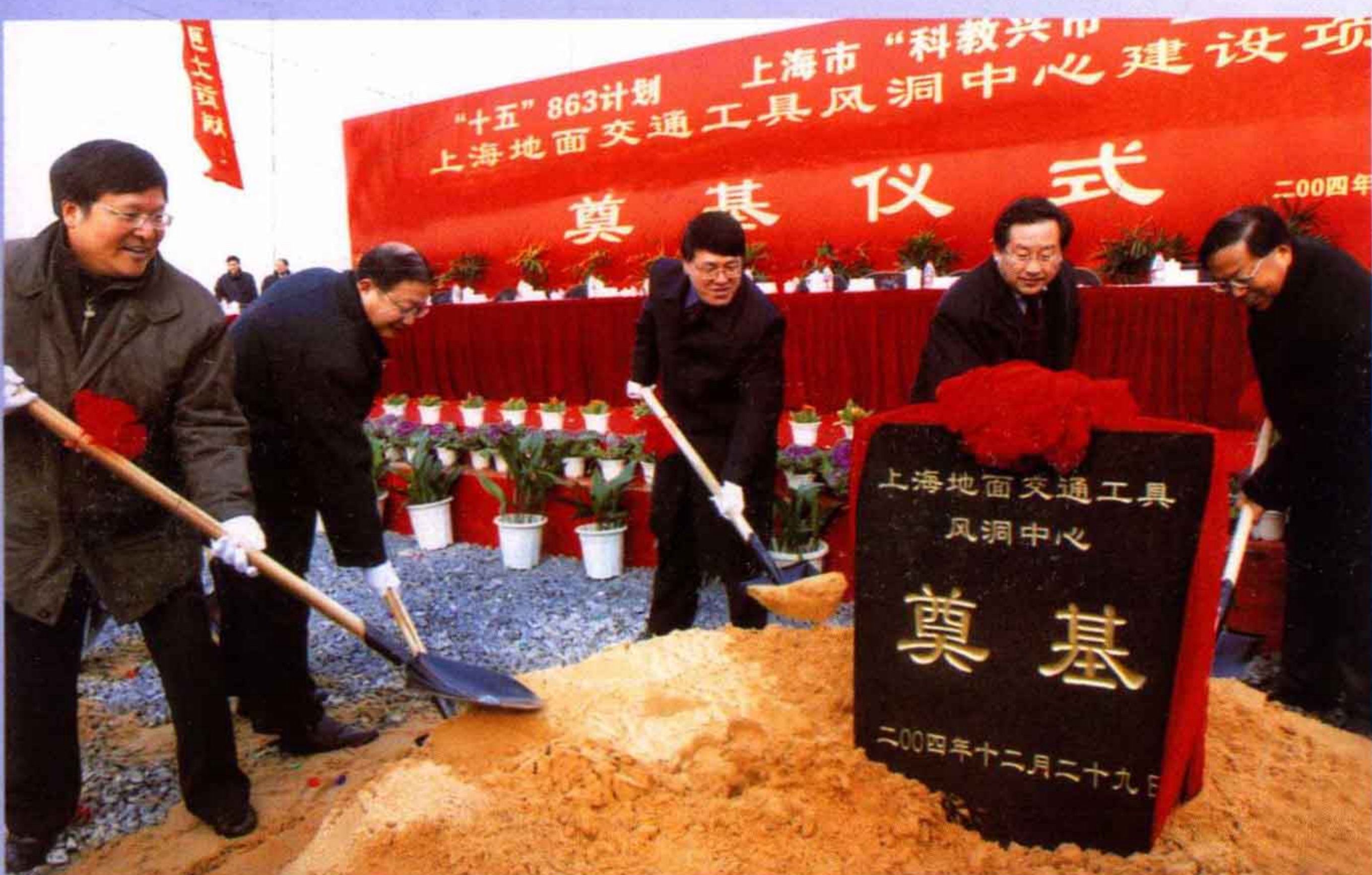
国内首个地面交通工具风洞中心在嘉定校区开工
