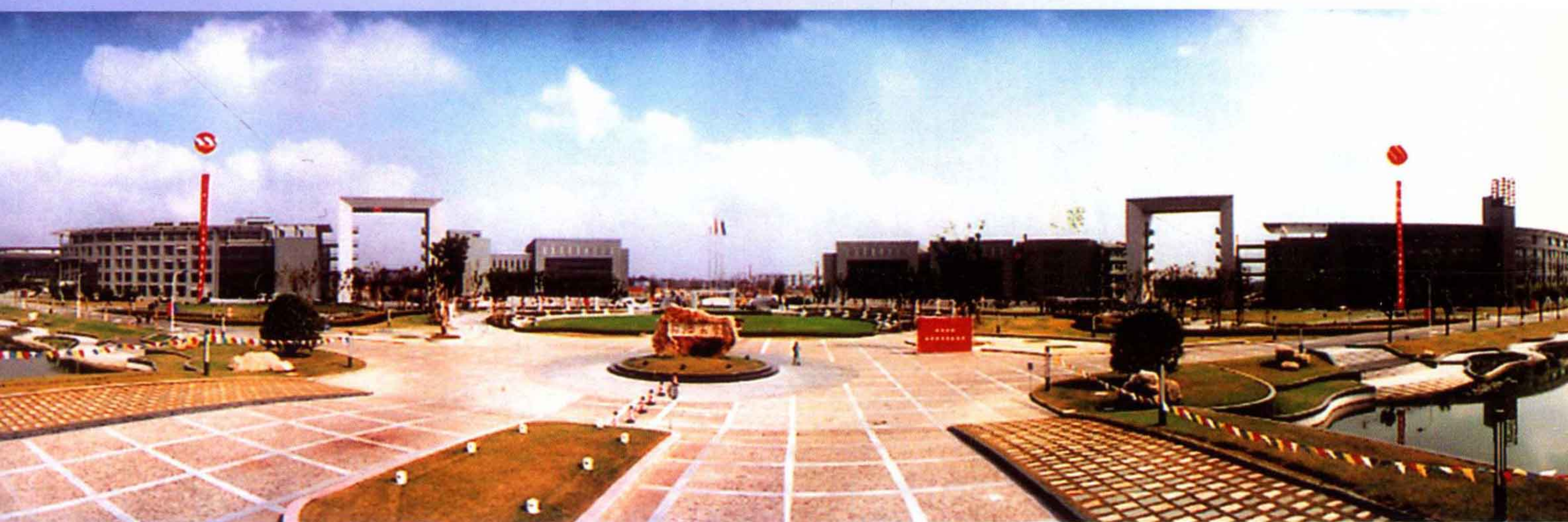
正在建设中的嘉定校区
