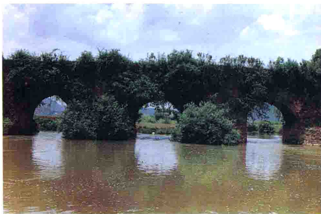
龙泉渠桥背水
