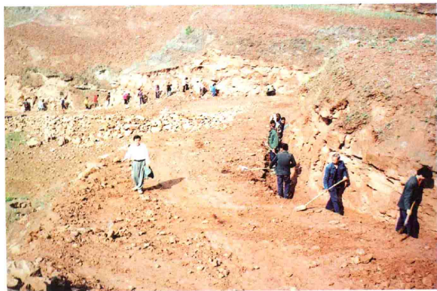
闵德伟同志身患绝症仍奔忙在修路工地上
