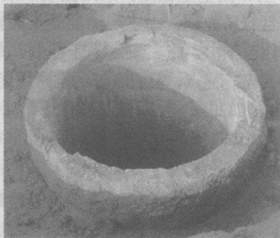
图 1-1 现场 PCC 桩头开挖图
