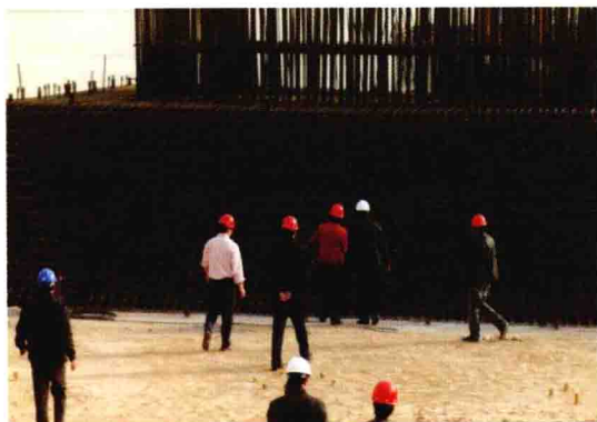
图 1-3 塔座钢筋全图
