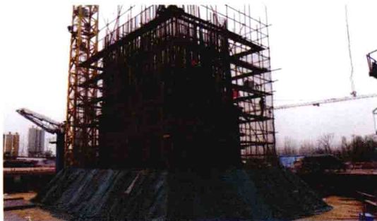
图 1-8 塔座浇筑完后覆盖保温
