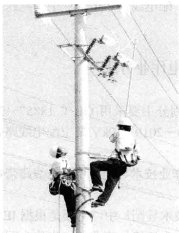
图 1-6 绝缘杆作业法（间接作业法）
