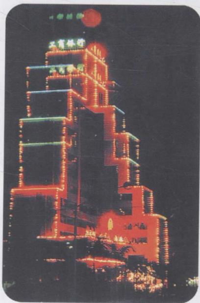
市工商银行步步高大楼
