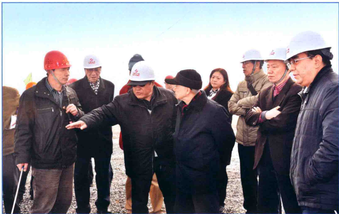
■ 2011年3月，国务院南水北调工程建设委员会专家委员会组织专家考察南水北调中线焦作市区段现场施工情况。 (冯晓波摄)
