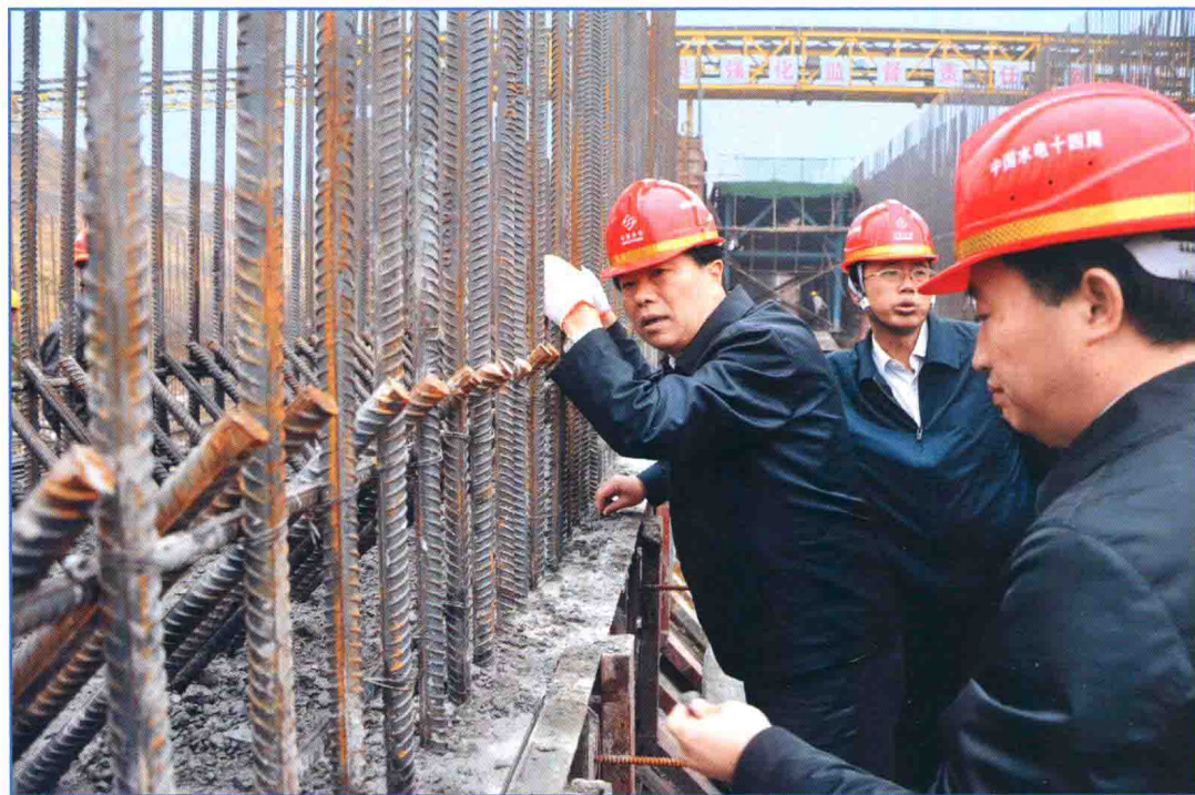
■ 2011年1月，国务院南水北调办主任鄂竟平在南水北调中线一期工程白河倒虹吸工程工地检查钢筋绑扎质量。 (综合司 供稿)
