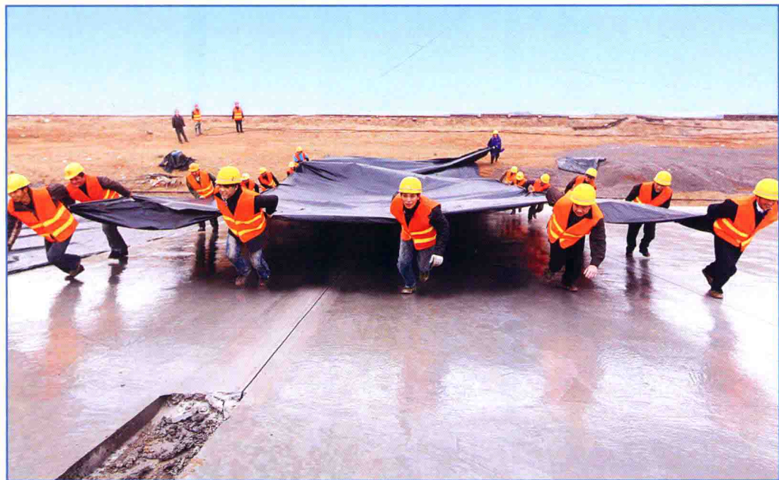
■ 2011年11月，南水北调中线一期工程漳河北—古运河南段工程工人们正在雨中铺盖石家庄市岳村渠道混凝土面板。
