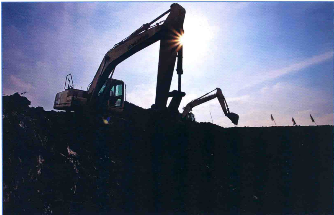
■ 2011年9月，夕阳映衬下的南水北调东线一期工程睢宁二站工程大型机械设备施工现场。
