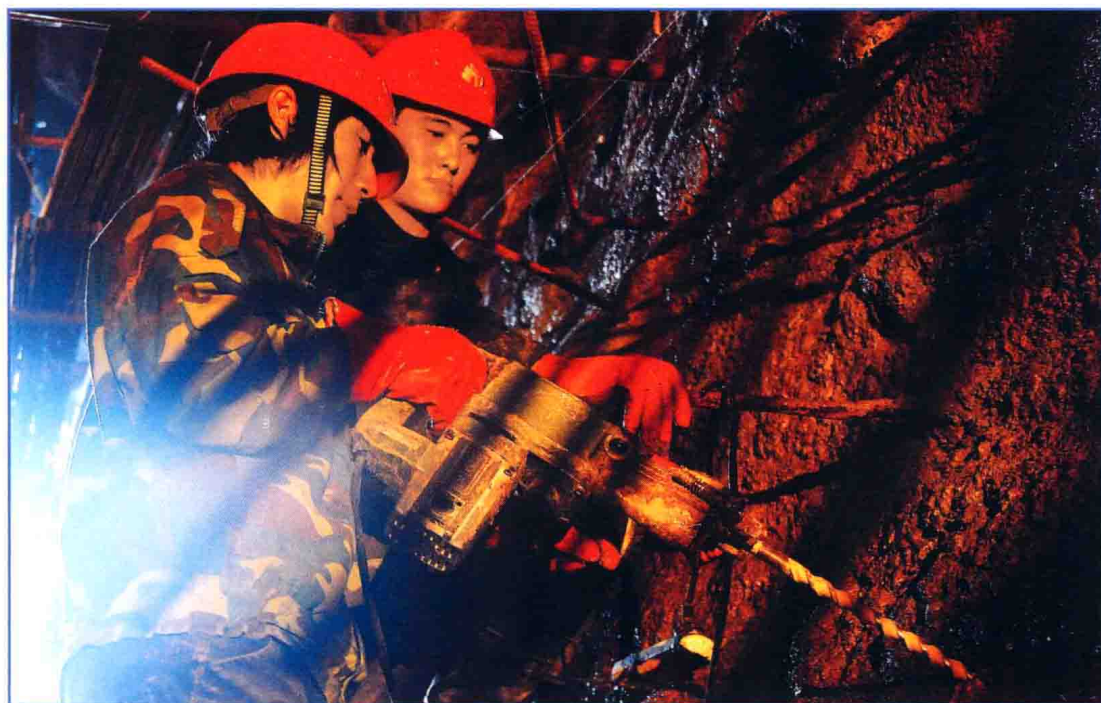
■ 2011年9月，南水北调东线一期工程穿黄河工程穿黄隧洞钻孔施工。（李志杰 摄）
