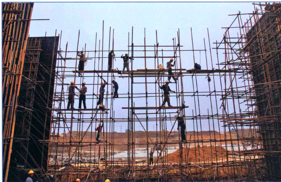
■ 2011年4月，正在紧张建设的南水北调东线一期工程泗洪站工程。
