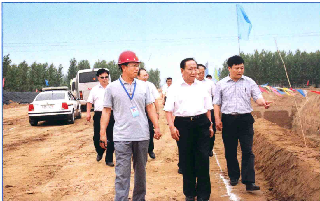
■ 2011年6月，河北省省政府顾问张和在廊坊市考察南水北调配套工程廊涿干渠工程建设情况。 (于正平 摄)
