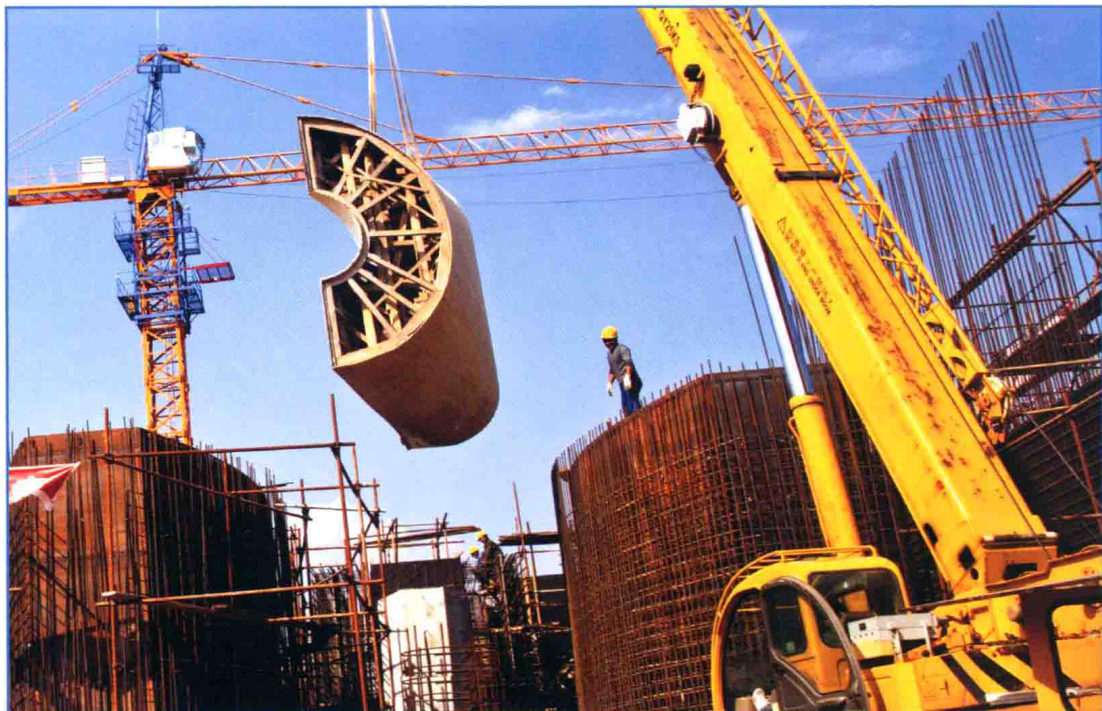
■ 2011年9月，南水北调东线一期工程邳州站流道模板吊装现场。
