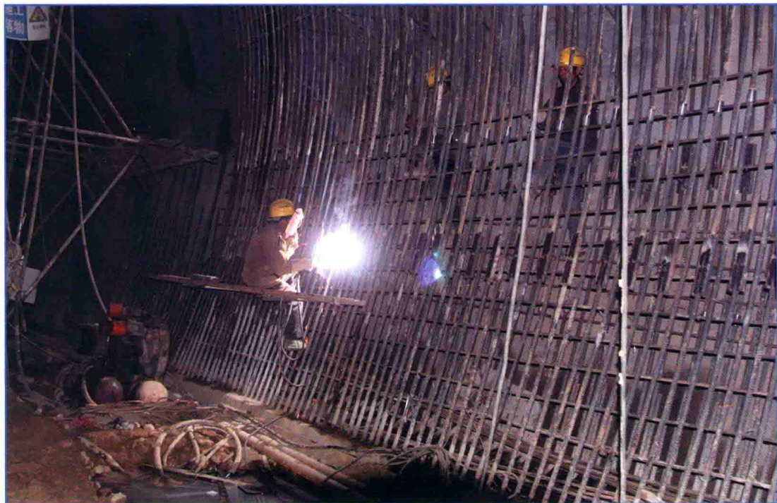
■ 2011年11月，南水北调中线一期工程焦作2段工程山门河暗渠隧洞内钢筋捆扎与焊接施工现场。
