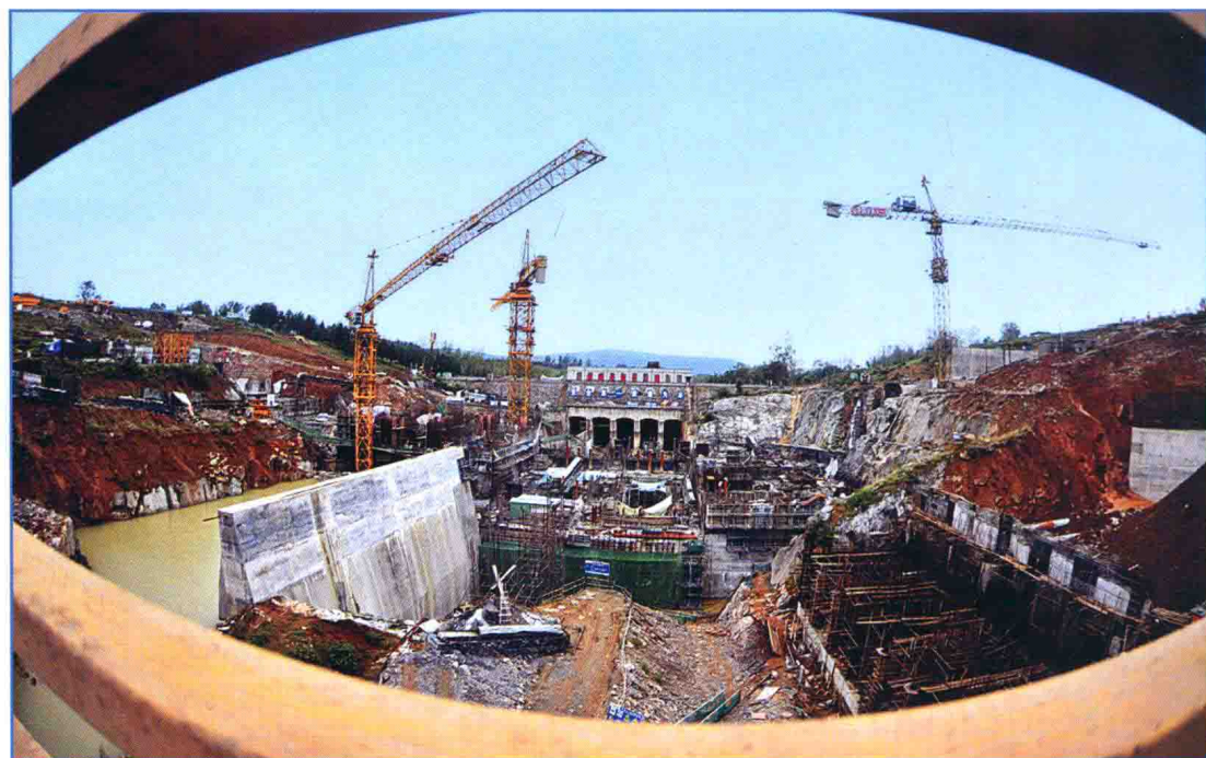
■ 2011年10月，南水北调中线一期工程陶岔渠首工程施工现场。（中线建管局 供稿）
