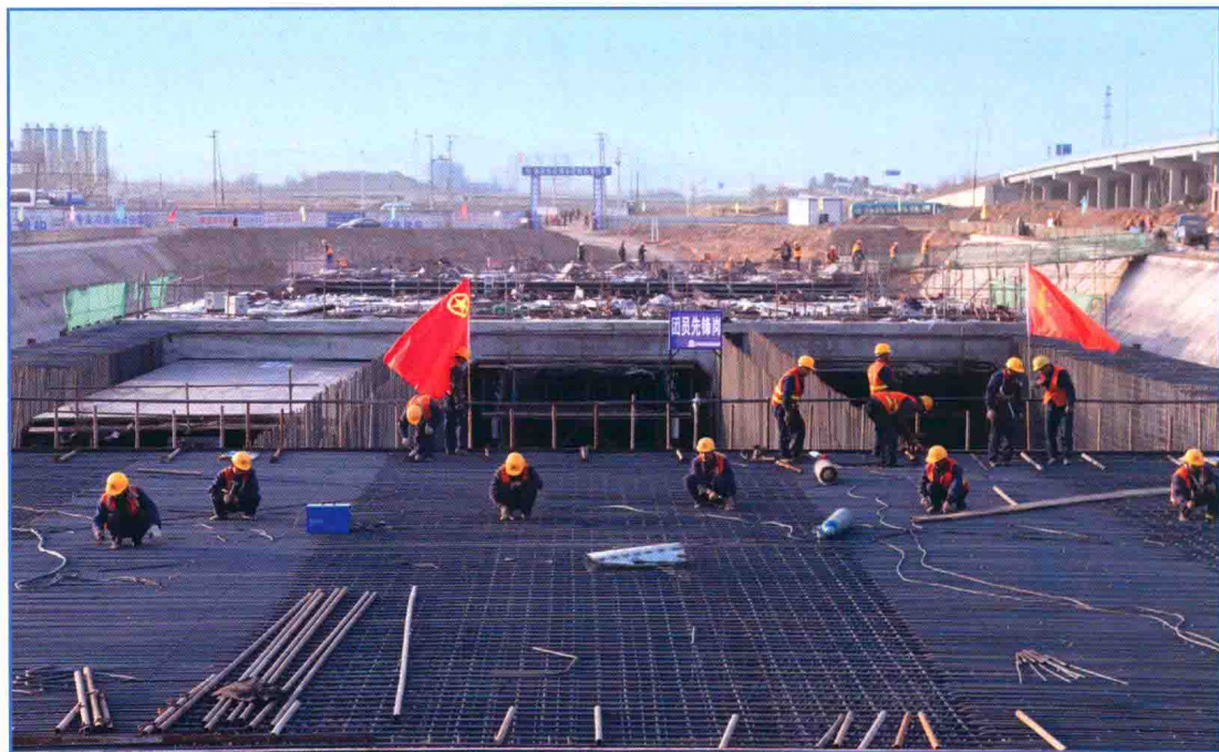
■ 2011年3月，南水北调中线一期工程漳河北—古运河南段工程SG14标开展创建青年文明号活动。图为该标青年突击队在钢筋绑扎现场紧张施工。
