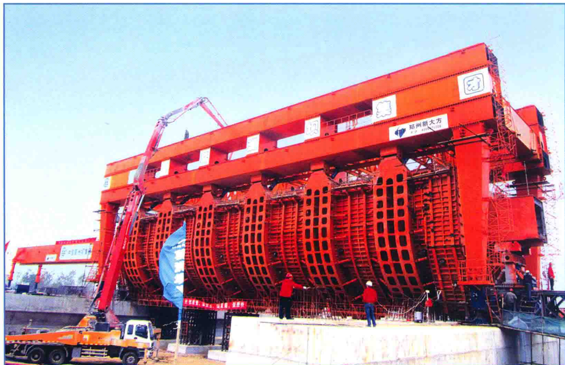
■ 2011年11月，南水北调中线一期工程湍河渡槽工程首樑混凝土浇筑成功。（许安强 摄）
