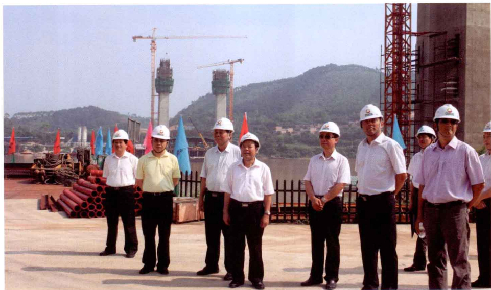
2012年5月17日，广西壮族自治区人民检察院检察长张少康（左四）实地察看南宁外环公路项目大冲邕江特大桥建设情况（杜景/摄）
