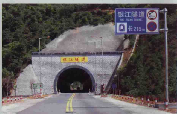
省道大梅线银江隧道(县志办供)
