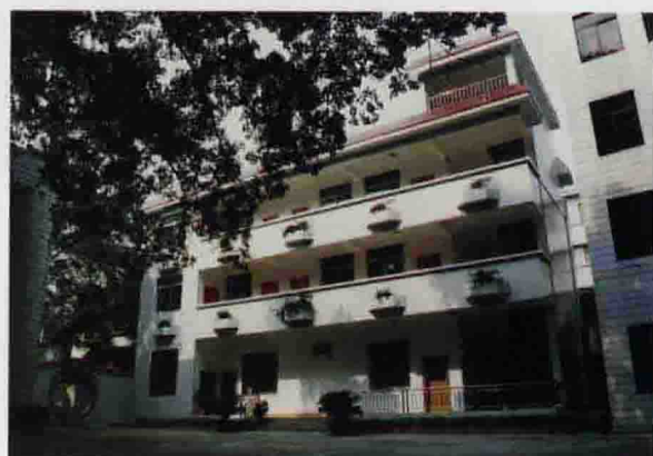
县国土资源局近3年来投入资金286万元,完成了14个基层国土资源所的所址建设。图为环境优美的茶阳国土资源所。
