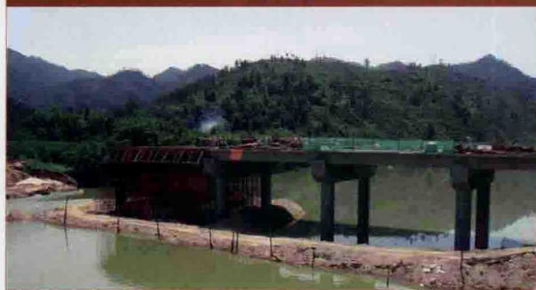
正在兴建的长上线岭下白云大桥
