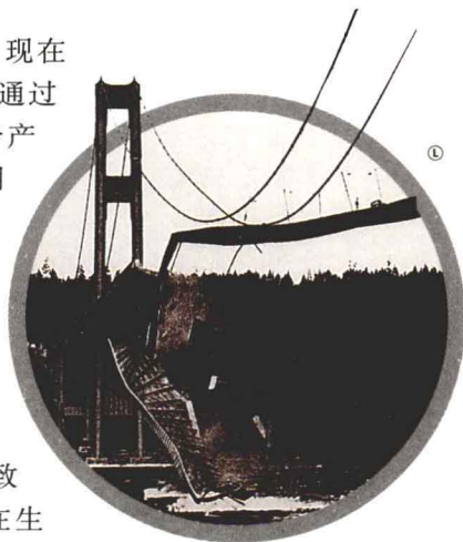
正在垮塌的塔科马海峡大桥
