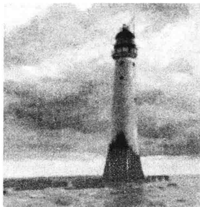
图 1.7 1756 年用水硬性石灰和火山灰建造的埃迪斯顿灯塔
