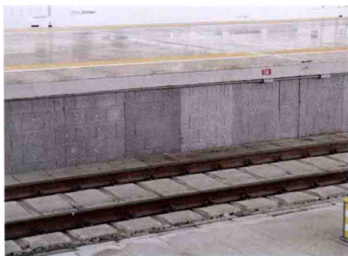
图 1.3 北京南站站台敷设吸声材料
