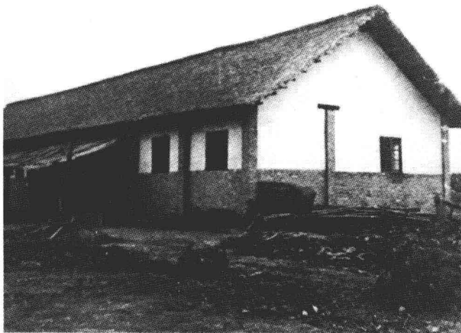
当时全厂仅此一座临时澡堂
