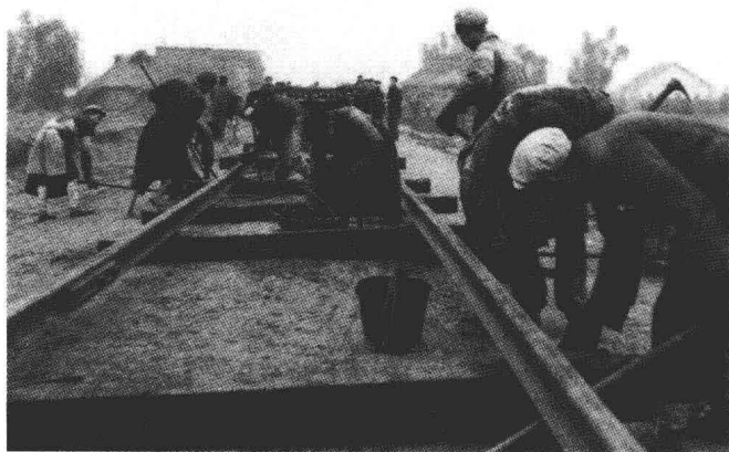
自己动手，铺筑铁路
