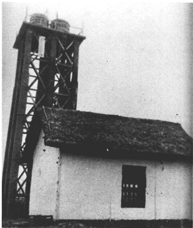
修建木质水塔，解决生产、生活用水难题
