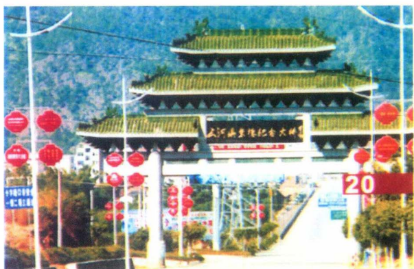
■ 三河坝朱德纪念大桥
