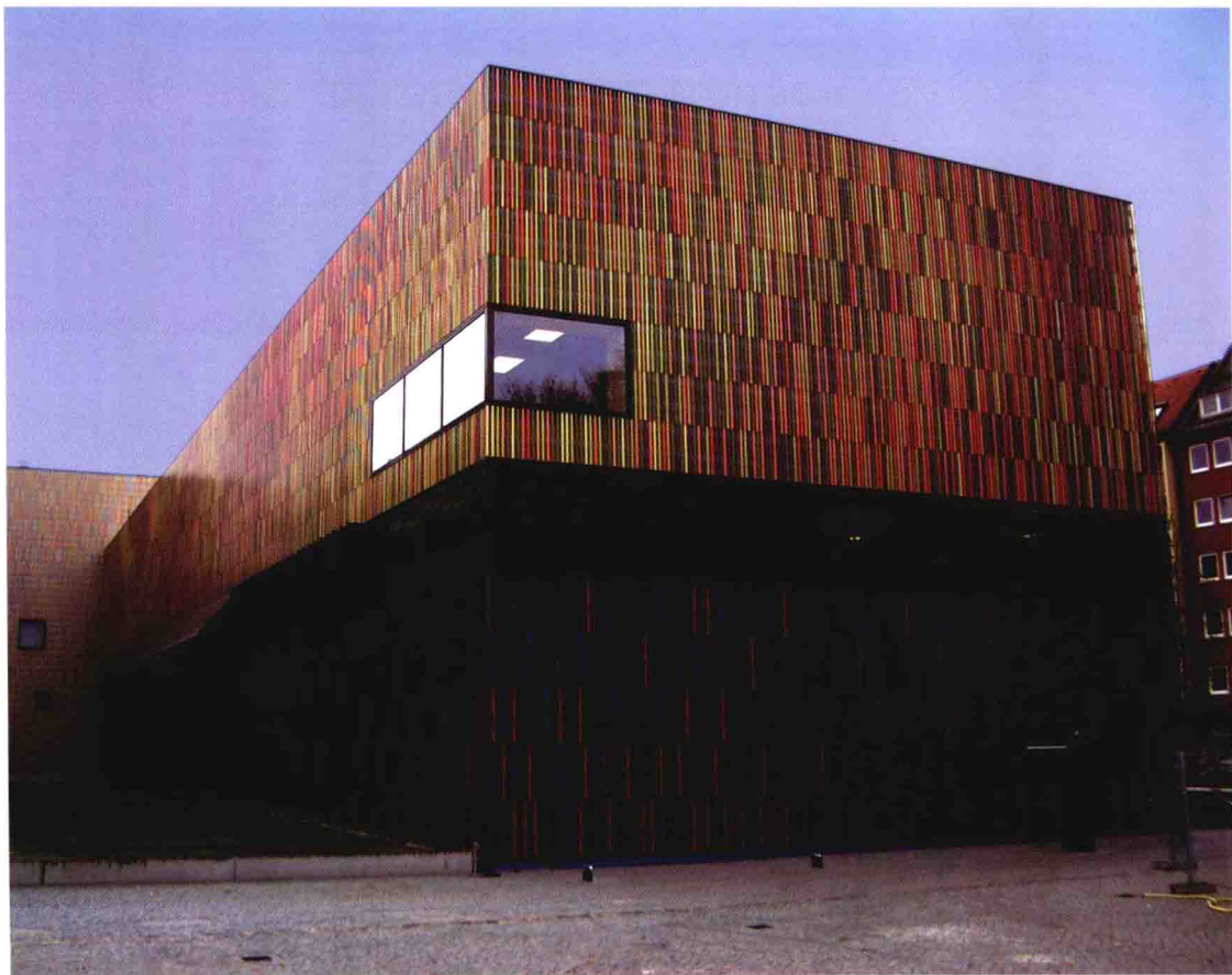
图 3 慕尼黑 Brandhorst 美术馆 Sauerbruch Hutton
