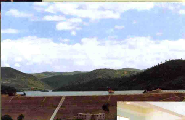
除险加固后的新村水库外坝坡
