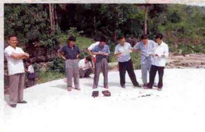
水电局的同志在施工现场指导工作
