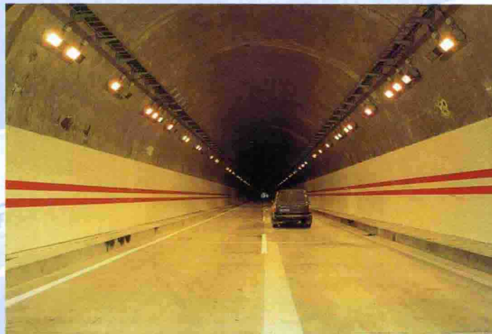
省路桥一公司修筑的隧道
