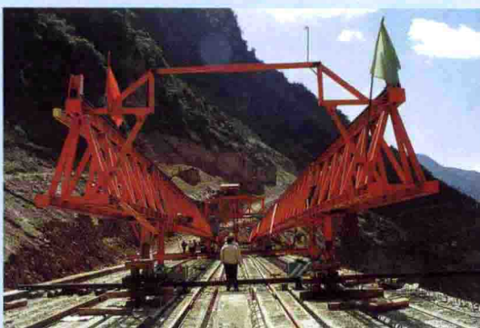
省路桥一公司架桥机正在施工
