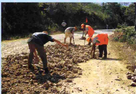
养路工人在修补弹石路
