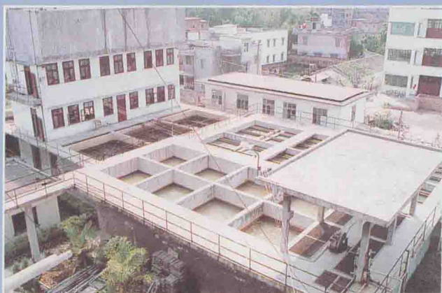
水廠製水車間
