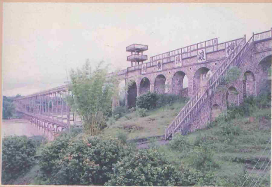
五華桐樹潭渡槽
