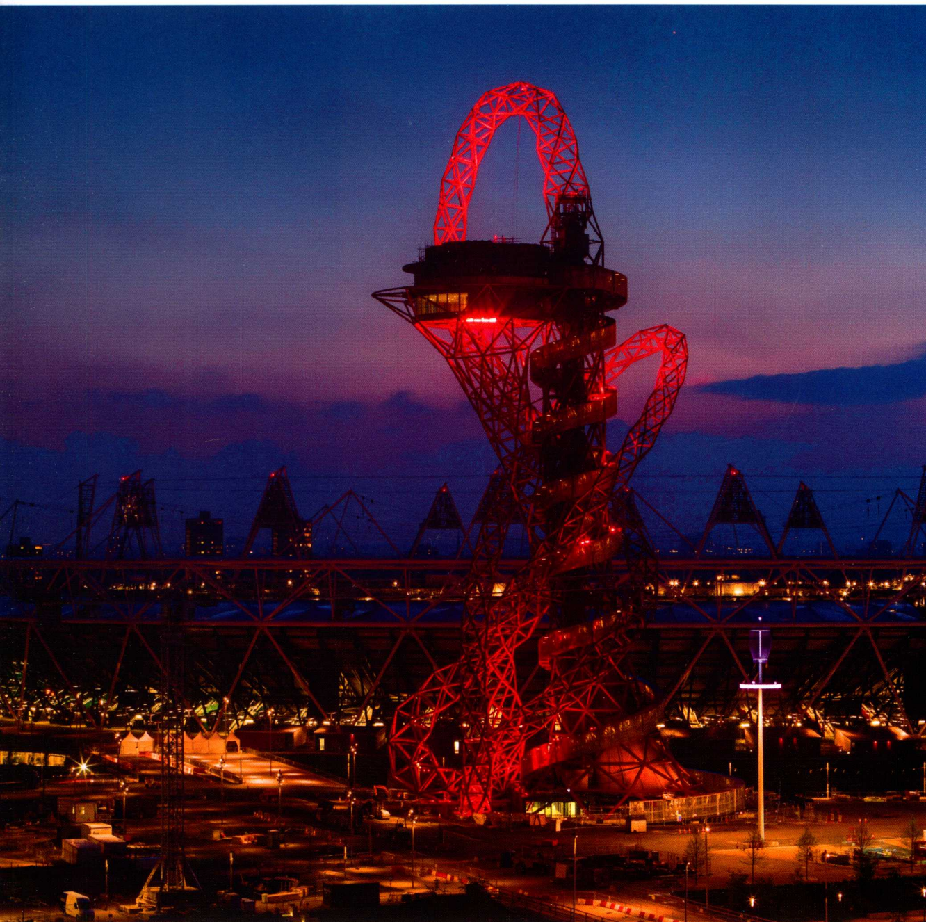
阿塞洛·米塔尔轨道塔，一个融艺术、建筑和工程于一体的独特作品，为伦敦的天际线提供了一个新的标志性景观。它是由雕塑家安尼施·卡普尔（Anish Kapoor）和结构建筑设计师塞西尔·巴尔蒙德（Cecil Balmond）合作设计，由阿塞洛·米塔尔（ArcelorMittal）钢铁公司赞助，摄影：伦敦遗产开发公司
