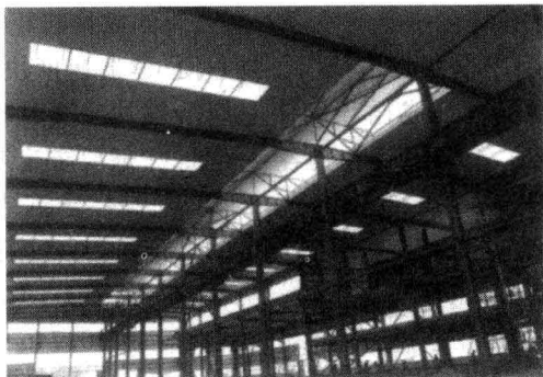
图 1.2.5 轻型钢结构厂房
