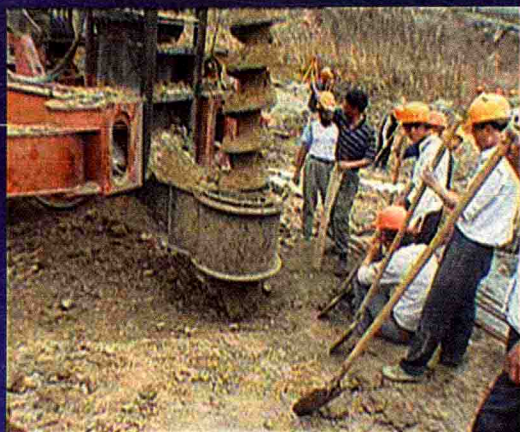
长螺旋钻孔机及灌注桩施工（录像）
